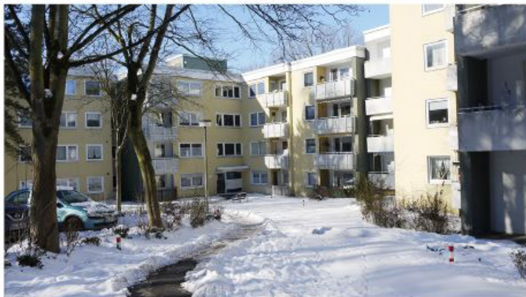
In dieser Wohnanlage in Bochum-Werne fiel seit 10 Jahren immer wieder die Heizung aus. Erst nach Androhung einer Mietminderung durch mehrere Mietparteien wurde endlich repariert.
