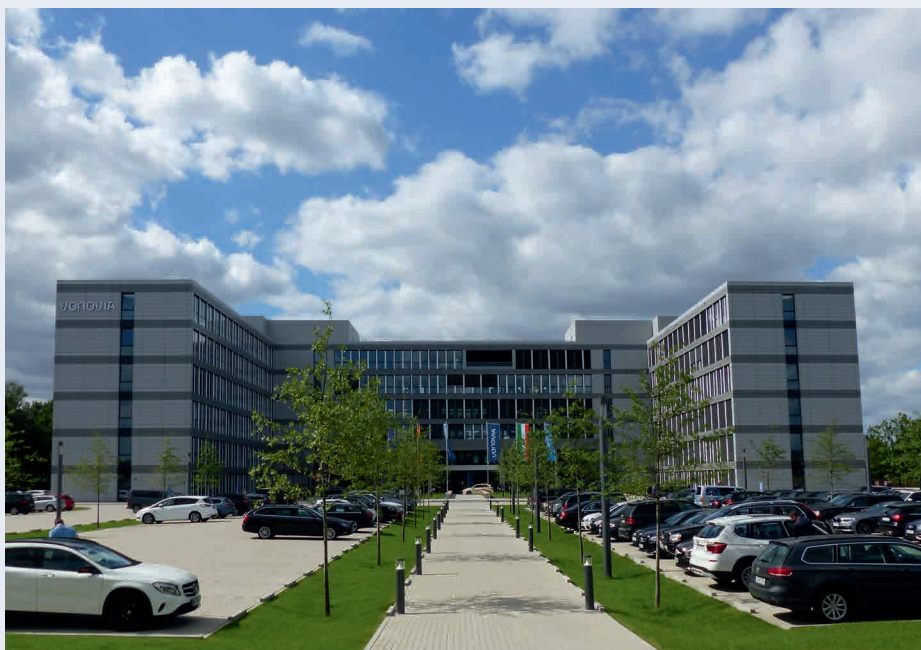
Konzernzentrale der Vonovia an der Universitätsstraße in Bochum: Hier und in 40 weiteren Niederlassungen suchte die Staatsanwaltschaft nach Beweisen für Korruption.
